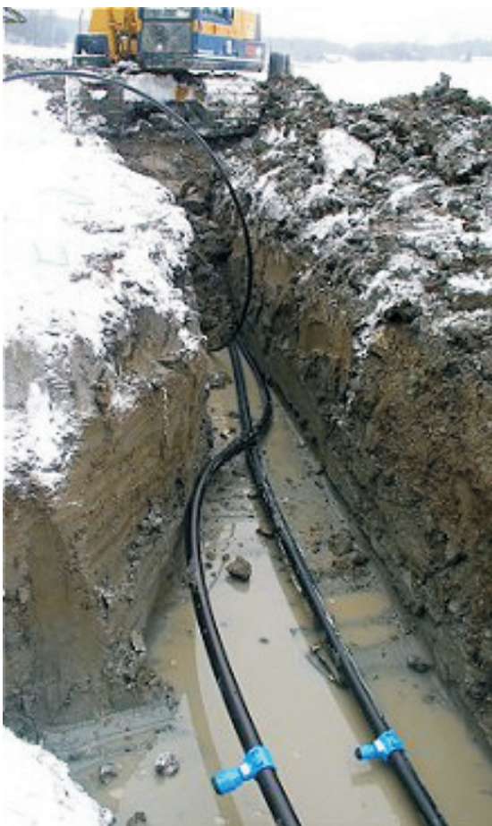
Tonttiliitoskohdat putkikaivannossa, Etelä-Pornaisten vesiosuuskunta.
